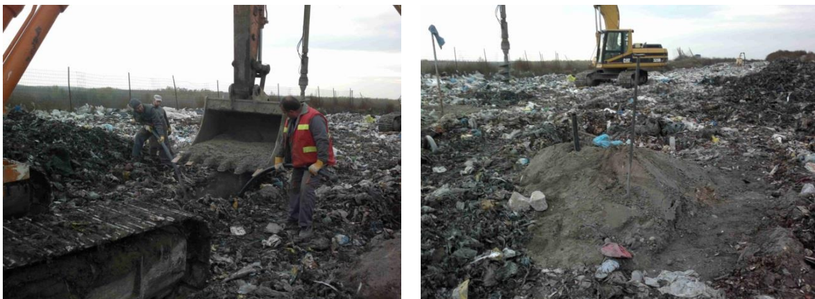
13. ábra: A függőleges kutak kialakítása.
