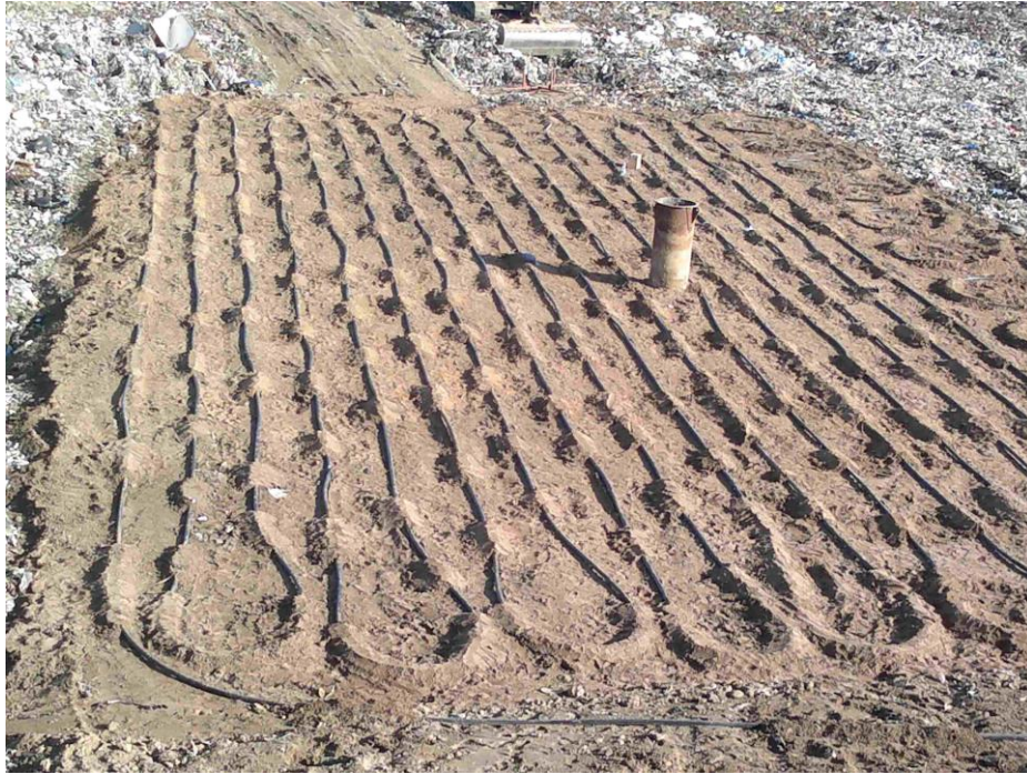
15. ábra: A „slinky” és a „piskóta” típusú vízszintes hőcserélők takarás előtt. (Erdélyi Attila 2014)
